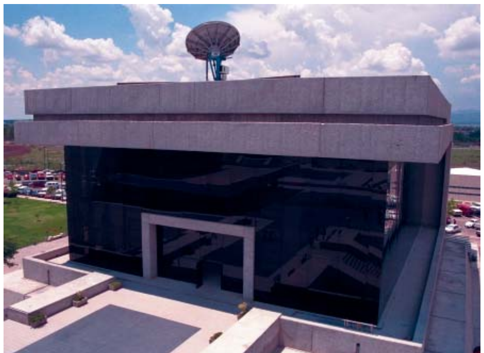
Edificio de informática del INEGI. Uno de los ejes modernizadores del Instituto fue la adopción de nuevas tecnologías.
